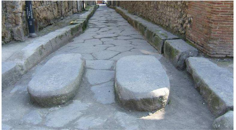
Dès l'Antiquité, dans les villes et aux carrefours, il a fallu organiser et réglementer la circulation des véhicules et des piétons. On peut voir ici le reste d'un passage piéton romain de Pompéi. Il a été dimensionné pour le passage des chars tirés par des bœufs ou des chevaux. Photo : Piscis13
