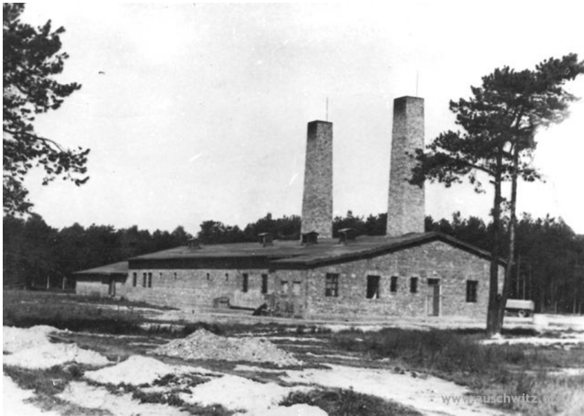
Malgré les apparences, il s'agit bien d'une chambre à gaz et de fours crématoires au Krematorium IV . Photo : SS, 1943. Auschwitz-Birkenau State Museum Archives. Source : www.auschwitz.org
